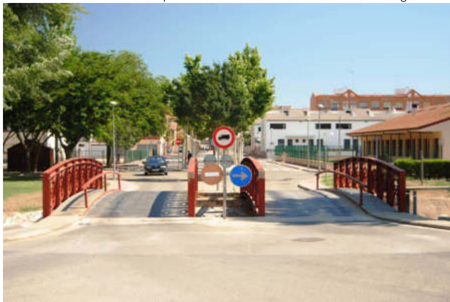
Foto 3. Pont metàl·lic per a vehicles i vianants del Carrer del Passeig Nou.
